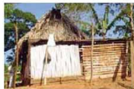
(Figure 14) Gestion environnementale et amélioration de l'habitat pour la protection individuelle à Oaxaca, Mexique. Source : Mendez-Galvan (2008).
