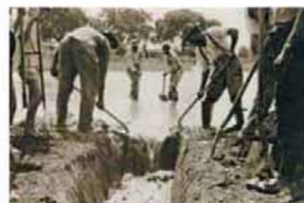
(Figure 9) Des ouvriers pratiquant « le contrôle du vecteur » en creusant un canal de drainage (Sud des Etats Unis). Source : CDC (1920s)
