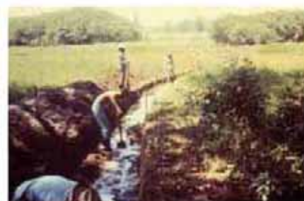
(Figure 5) Reconstruction d'un canal de drainage pour permettre en permanence le mouvement de l'eau dans une région sujet au paludisme. Source CDC (1981)
