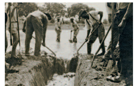
(Abbildung 9) Im Rahmen der Malariabekämpfung wird ein Entwässerungskanal ausgehoben (südliche Vereinigte Staaten, 20er Jahre). Quelle: CDC
