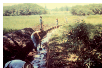
(Abbildung 5) Ein verstopfter Entwässerungskanal wird gereinigt, damit das Wasser wieder ungehindert fließen kann (1981). Quelle: CDC
